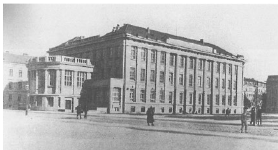
Zgrada na Marulićevom trgu 20 u kojoj Zavod neprekidno djeluje od utemeljenja
